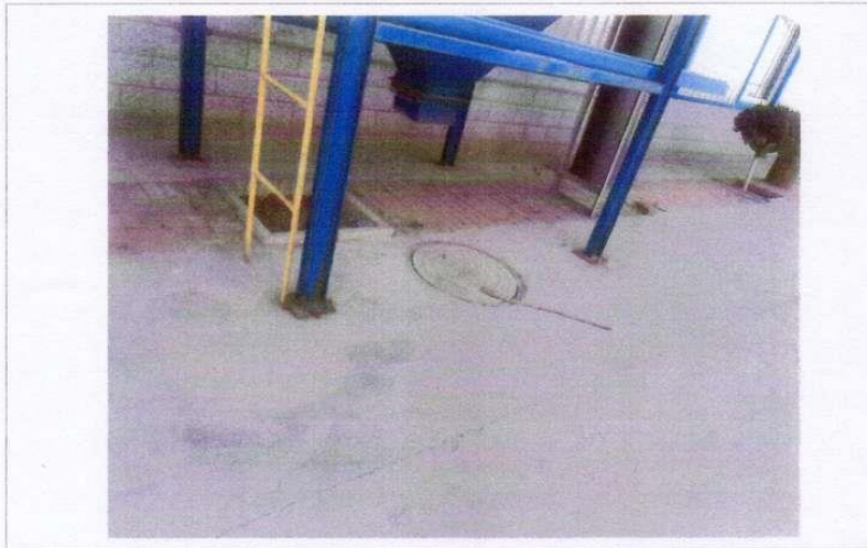
图 3-5 化粪池现场照片
