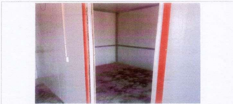
图 3-6 危废间现场照片
